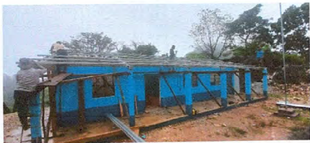
Foto1: Estan colocando las costaleras de metales para el entechado del edificio escolar con el apoyo de los padres de familias.
