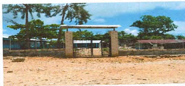
Foto 4: colocacion de mallas sobre el muro.
