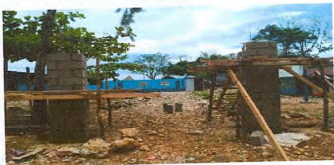
Foto 5: levantamiento del base del porton.
