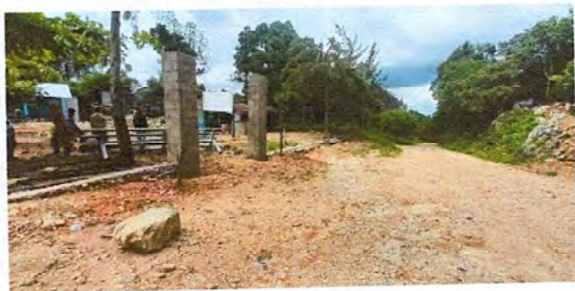
Foto 3: colocacion de cimientos para el block del muro perimetral.
